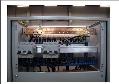
L'unité de distribution AC standard est conçue avec un rail DIN 35 mm, un répartiteur Multiclip et des barrettes de raccordement N/PE en cuivre, l'unité fait partie de l'armoire.
